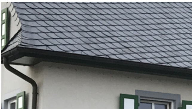
Negativ: überdimensionierter Dachüberstand (ortsuntypisch)
