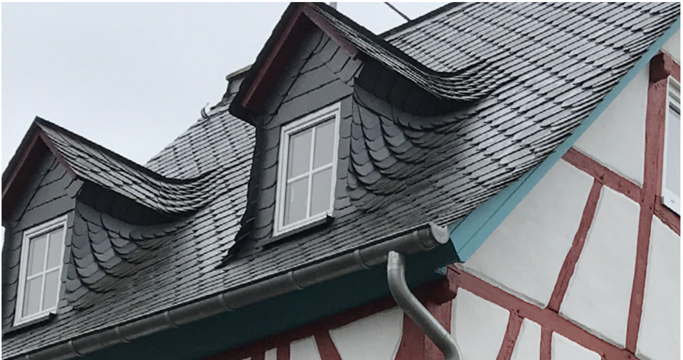
Positiv: Saniertes Fachwerkhaus mit Schiefereindeckung und Satteldachgauben (ortstypisch)
