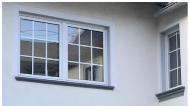
Negativ: aufgeklebte Fenstersprossen
