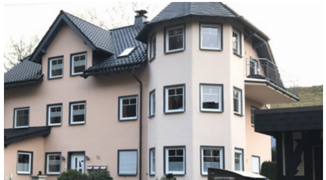
Gestalterische Disharmonie, Turm wirkt überdimensioniert
