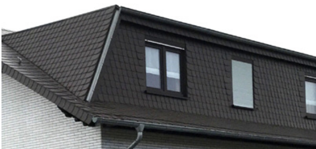
Negativ: Unpassende Dachgauben (in puncto Form, Größe)
