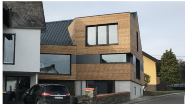
Moderner An-/ Neubau stellt Gestaltbruch dar und wirkt überdimensioniert
